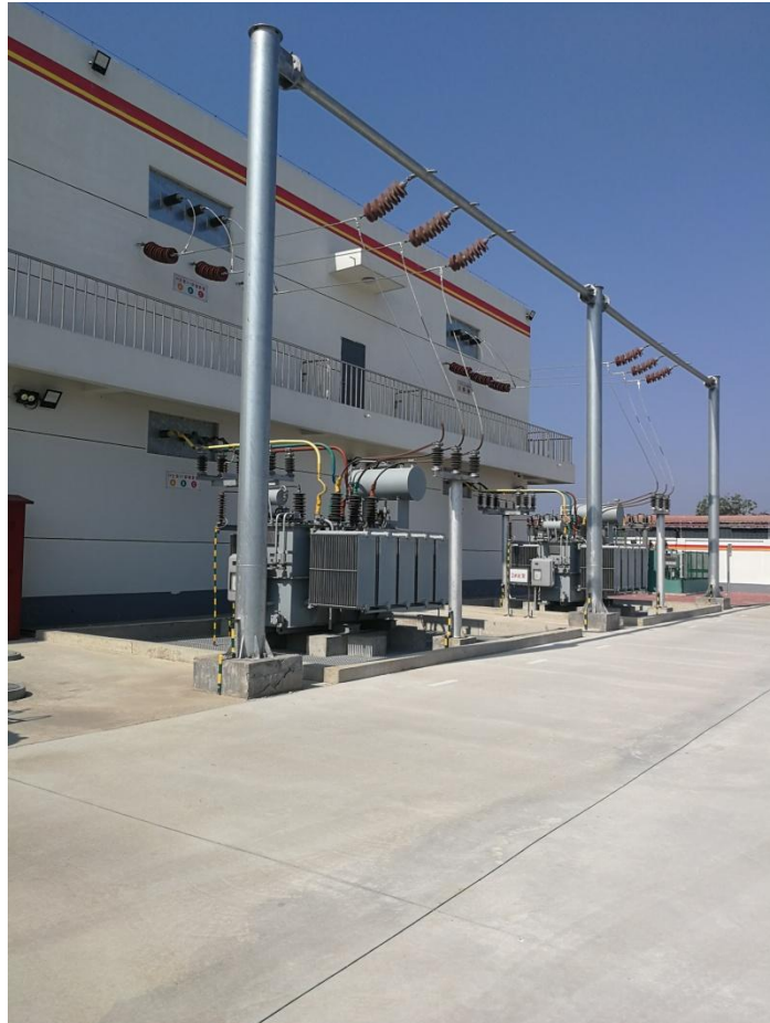
35KV 变压器
